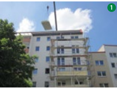
1 Eine weitere Balkonbodenplatte schwebt ein. 2 Der Balkonbau ist in vollem Gange.
