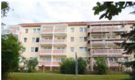
Kurz vor der Fertigstellung
